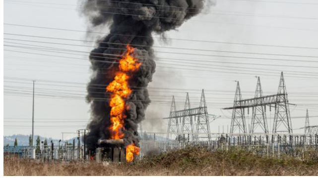
Şekil 3. Trafo patlaması sonucu oluşan bir yangın (Kaynak : T&D World)
