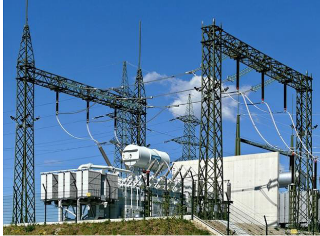
Şekil 2. Açık alan trafo grubu (Kaynak : pixabay)
